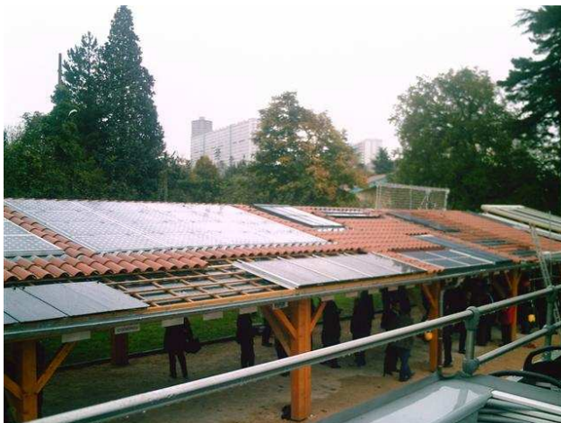
Plate-forme photovoltaïque pour la pose des modules
