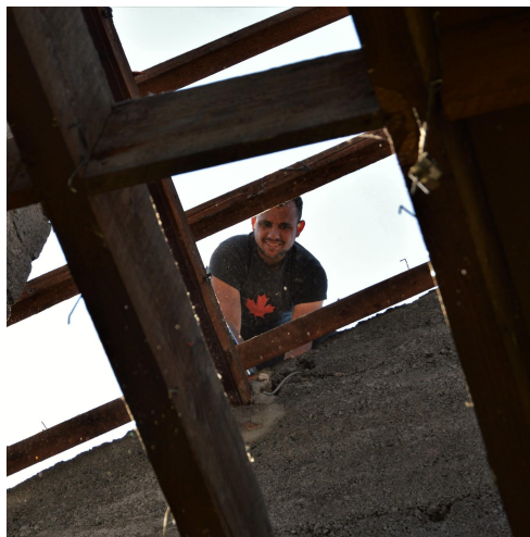
Charpente bois_ Sciage ou dépose au pied de biche selon le type d'assemblage
