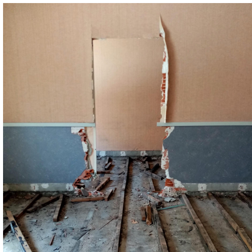
Parquet bois cloué_ Dépose au pied de biche et disqueuse
