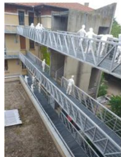
* Passerelles métalliques à découper sur le lot A
