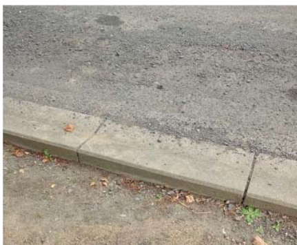
Caniveau CC1 autour de la halle de Mauzun
