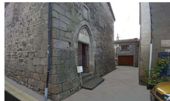
Pose en dallage faisant parvis devant l'église de Mauzun
