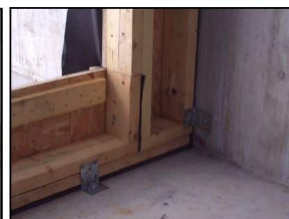
Fixations réglables des panneaux bois sur la structure béton - Le pare vapeur passe devant le nez de dalle
