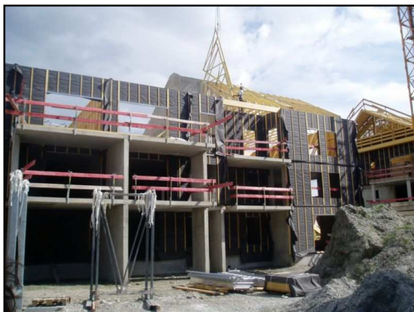
Bâtiment D, façade Sud - La pose des panneaux bois vient d'être achevée
