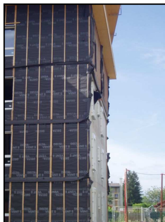
Bâtiment C, façade Nord
