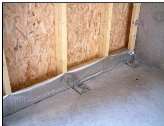
Pare-vapeur monté en avance sur le nez de dalle, venant ensuite recouvrir l'ossature bois
