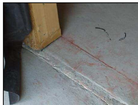
Isolant placé entre la dalle du balcon et le reste du bâtiment
