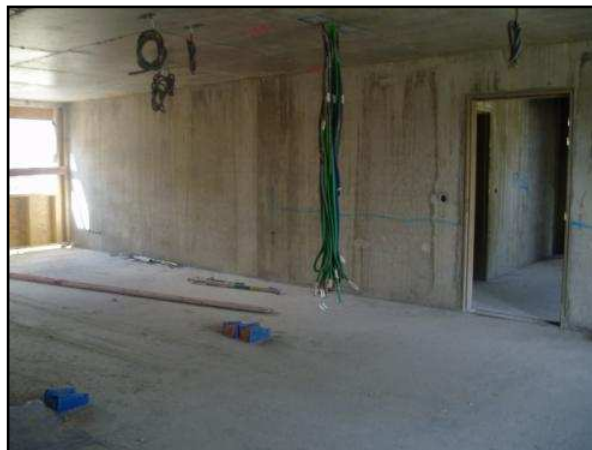
A l'intérieur, refends et dalles sont en béton armé
