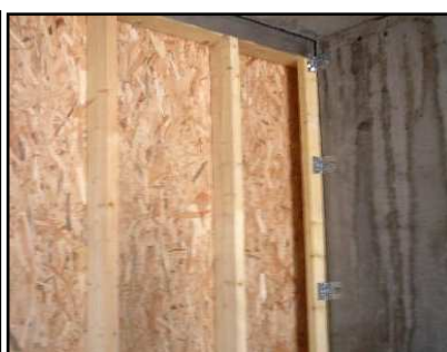
Fixations réglables des panneaux bois sur la structure béton - Le pare vapeur passe devant le nez de dalle
