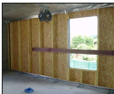
Fixations réglables des panneaux bois sur la structure béton - Le pare vapeur passe devant le nez de dalle
