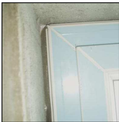
Détail d'utilisation de compribande sur les menuiseries
