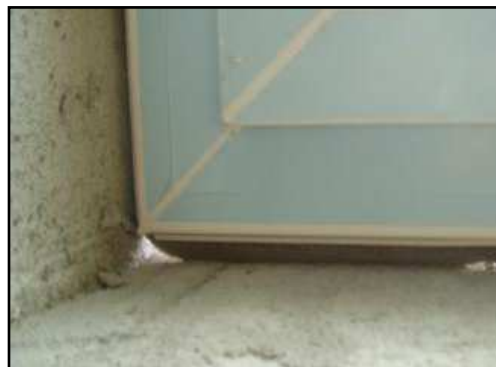
Jour entre une des menuiseries et le bâti en béton
