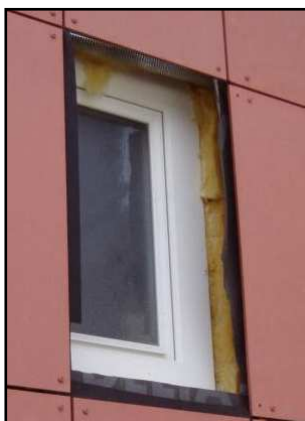
Détail menuiserie extérieure avant mise en place du tableau. On distingue la laine de verre, le pare-pluie et le revêtement de façade
