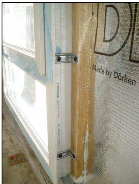
Menuiserie partiellement encastrée dans le panneau bois
