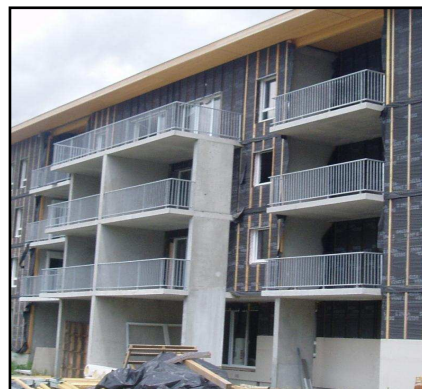
Bâtiment C - Balcons achevés
