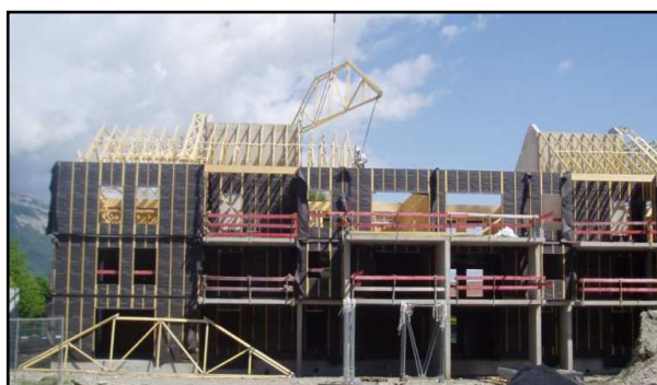
Bâtiment D, façade Sud – Une grue dépose une des fermettes de la charpente
