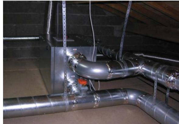
La ventilation Double Flux existante a été bien sûr conservée ; seules la prise d'air neuf et la sortie d'air rejeté ont dû être adaptées
