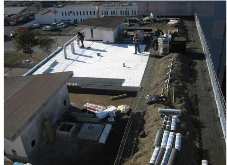
Isolation avec 290 mm de polystyrène ( $R=8,15 \text{ m}^2 \cdot \text{K}/\text{W}$ )
