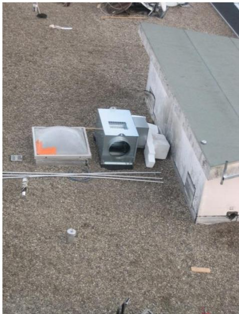
Remplacement des caissons de ventilation et mise en place de bouches d'extraction et d'entrées d'air hygroréglables dans les logements.
