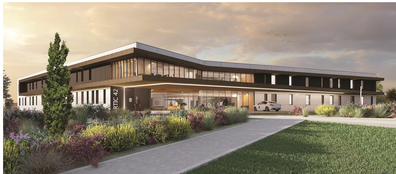
construction d'un centre de dialyse de 4700m 2 prévu pour mi 2019.
