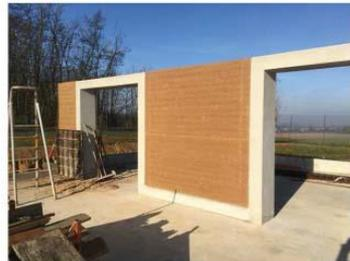
37m2 de murs ép. 40cm; compactage de la terre par couches de 10cm; réalisation 13nov - 2déc 2017; coût 350€ HT/m2
