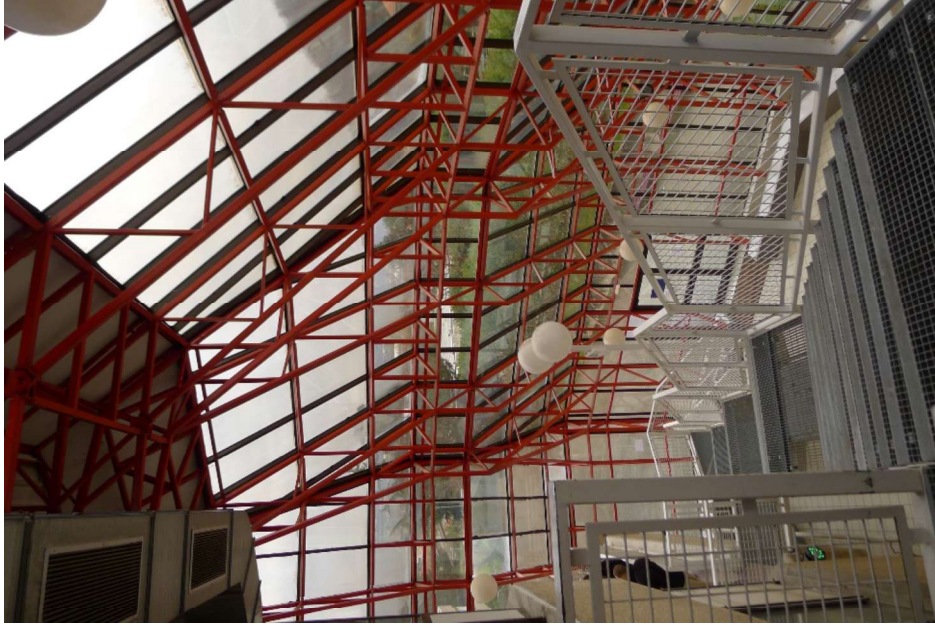
État des lieux – Vues à l'intérieur de la verrière
