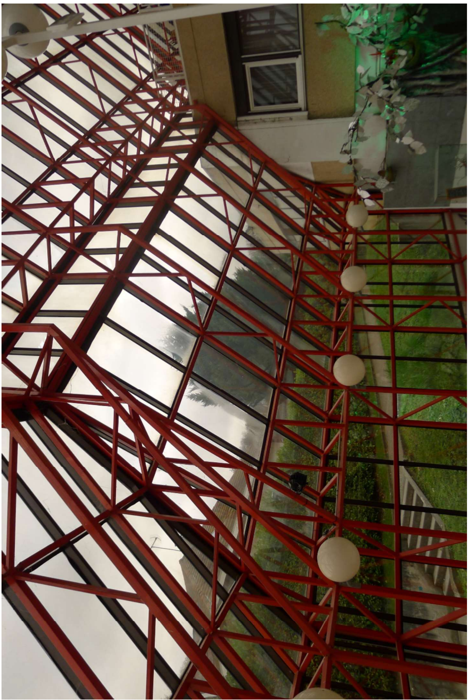
État des lieux – Vue à l'intérieur de la verrière
