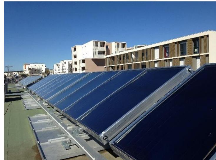
Rangée de capteurs (12 m<sup>2</sup>/capteur)
