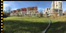
Début travaux secteur 1
