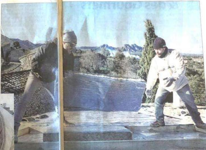
Les panneaux isolants, ici posés par Frédéric Rosso (à gauche) et son apprenti, sont enrobés de secteurs pour augmenter leur résistance thermique. "Contrairement à d'autres matériaux, comme la laine de verre, la fibre de paille n'émet pas de composants volatils allergènes et irritants", assure l'artisan. / PHOTO VALÉRIE FARINE
