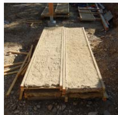
Panneau côté enduit
