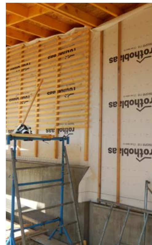
Préparation du support pour le torchis in situ
