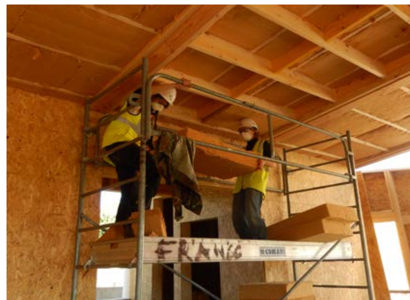
Pose de l'isolant en toiture
