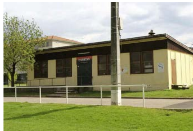
Photo du Club House avant les travaux (© Le Dauphiné)
