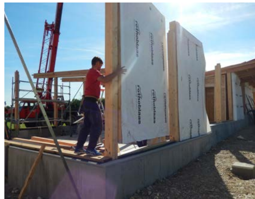
Mise en oeuvre des murs ossature bois
