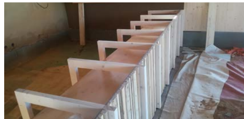
Bar en cours de montage (© Thibaut Defrance)
