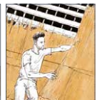
PAR RANGÉES SUCCESSIVES, LES BOTTES SONT POSEES SUR LE TOIT. LES TIGES DE ROSEAU SONT ÉTALÉES, FAÇONNÉES ET SÈCHÉES DANS DES LITTEAUX GRÉS AUX ANIMULES.
