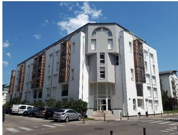
Photo après travaux
