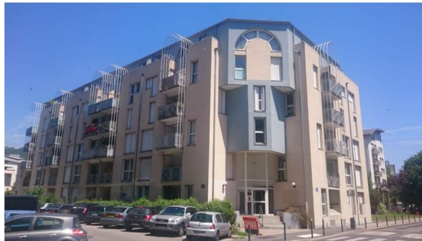
Photo avant travaux
