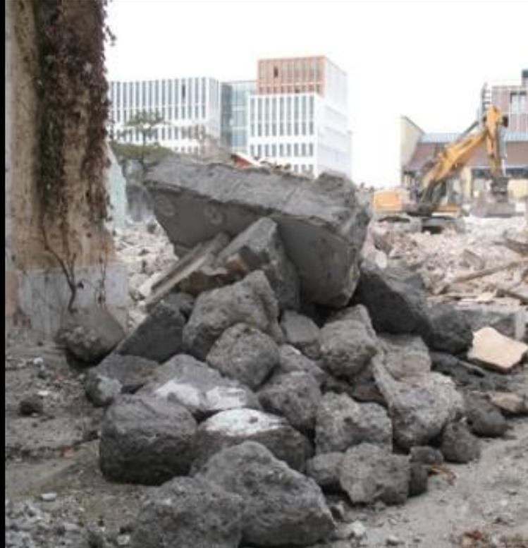
Blocs de béton de mâchefer banché sur un chantier de démolition à Lyon Gerland - © CAUE 2019
