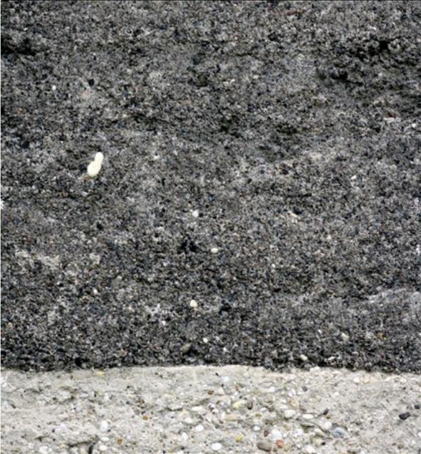
*Mur en béton de mâchefer sur un soubassement en béton de ciment*
