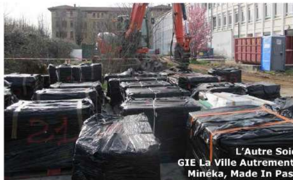
Le stockage et la traçabilité des matériaux déposés s'organise
