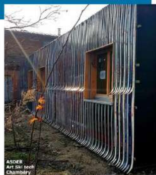
ASDER Arts & Tech Chambéry Detournement d'usage pour donner une seconde vie à d'anciens sacs et habiller un bungalow vétuste transformé en bâtiment de formation.
