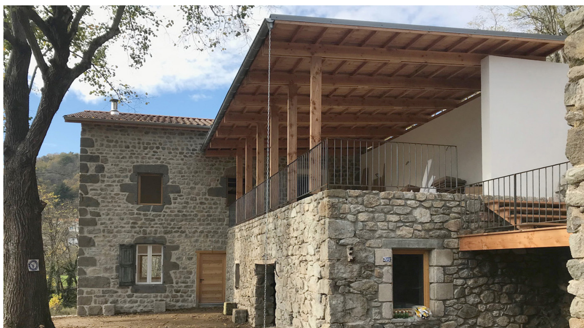
Rénovation d'une maison à Lamastre (07) avec réemploi de bois issus de démolition
