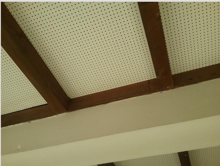
Plafond poutre en bois apparente et plaque antibruit
