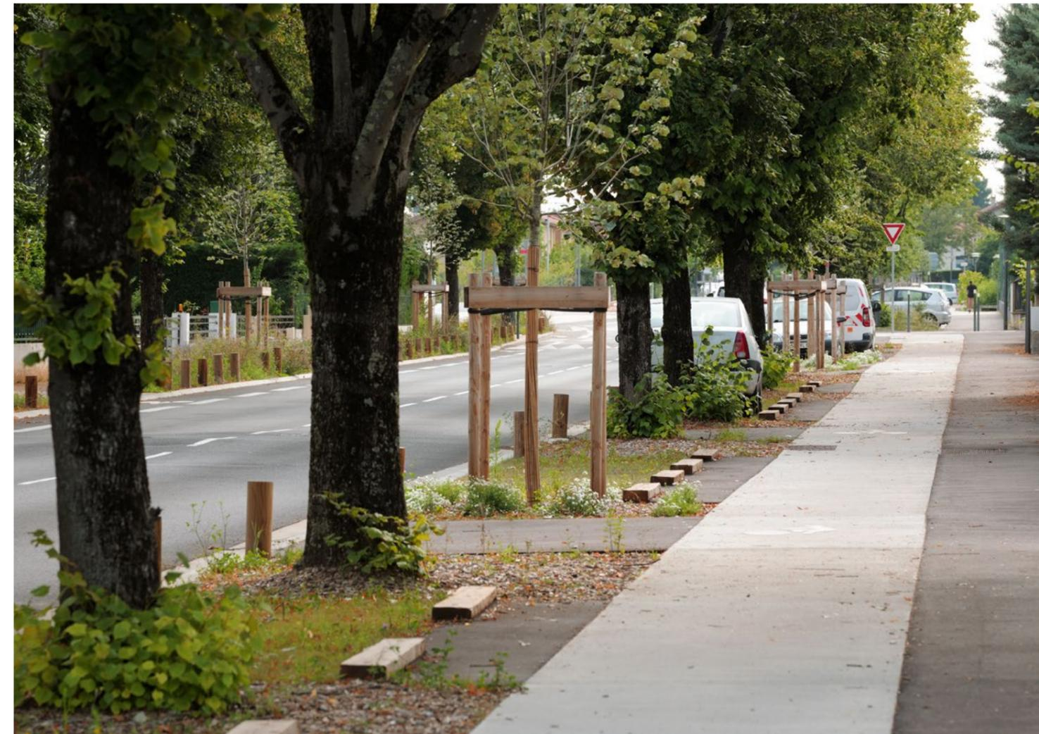
Projet de désimperméabilisation du sol, afin qu'il n'y ait aucun rejet au réseau sur 80% de l'emprise aménagée.
