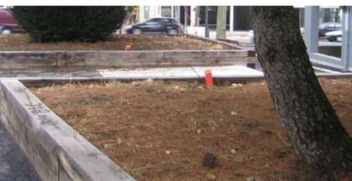
7 Mobilier pérenne de protection des arbres dans le stationnement en épis : basting bois Pin autoclave
