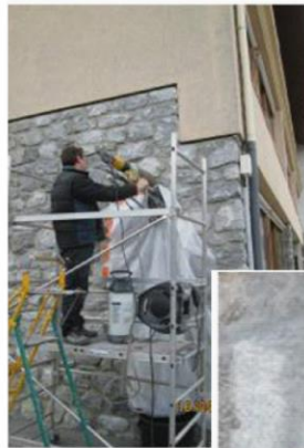
Carottage pour entrée et sortie d'air
