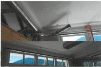
Air neuf dans la BCD par deux bouches de soufflage
