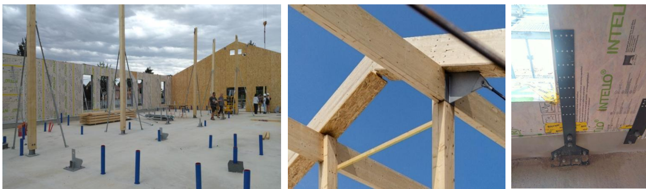
Figure 1 : Chantier du groupe scolaire du Fort © Lieux FAUVES
