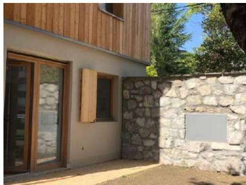
Mur en pierre construit avec les pierres d'une portion du mur d'enceinte démolie
