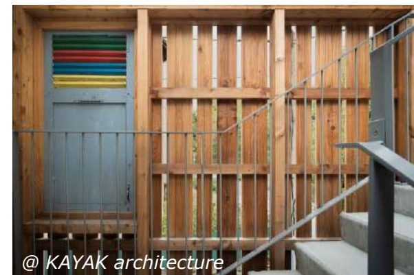
Réemploi des volets de l'ancienne maison des scouts, aux couleurs des foulards
