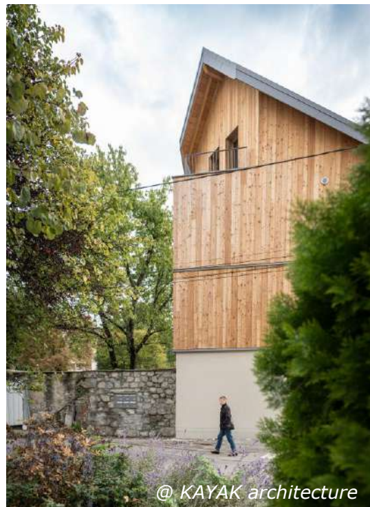
Mur en pierre construit avec les pierres d'une portion du mur d'enceinte démolie
