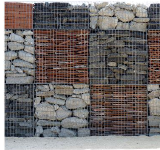
Réemploi de matériaux inertes en gabion - Déchèterie, Saint Martin d'Hères, NA architecte
