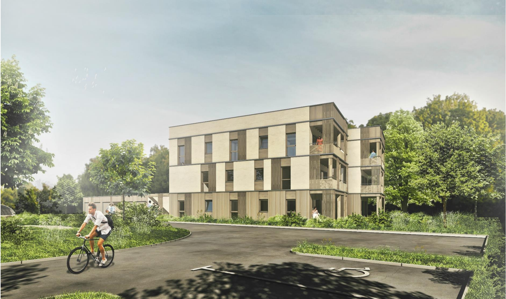
Vue depuis l'angle Sud-Ouest
