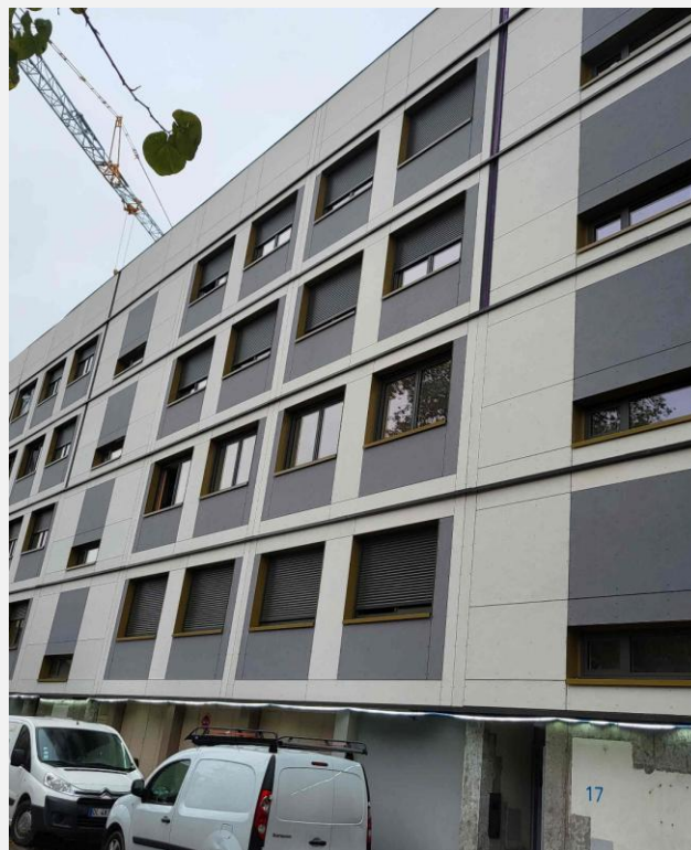
Bardage intégré, et réhausses d'acrotères en FOB
