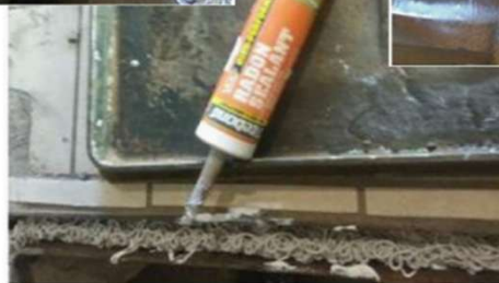
Pose de mastic Anti-radon : plinthes et regards
