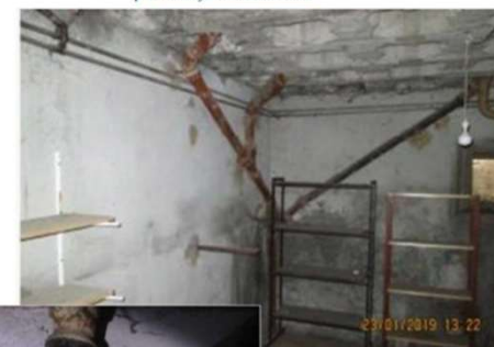
Découpage des anciennes canalisations (au niveau des caves) - fermeture par un joint étanche
