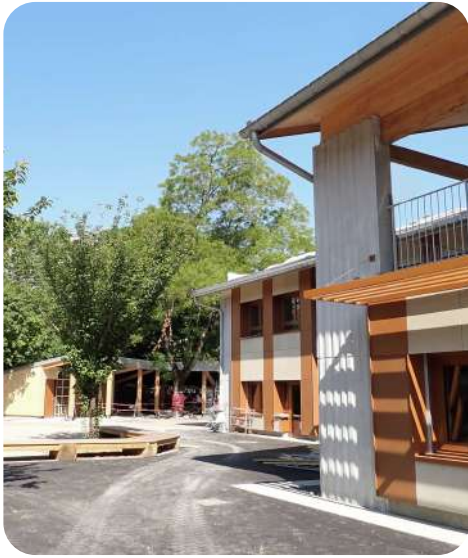
Façades travaux en cours ©Minéka
