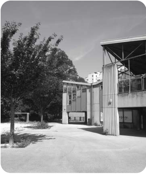
Façades avant travaux ©Minéka
