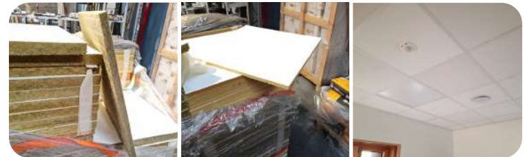
Stockage hors site & remise en œuvre
