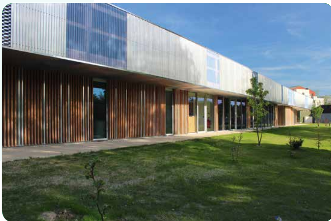
Façade Nord-Ouest © Colomes Nomdedeu
