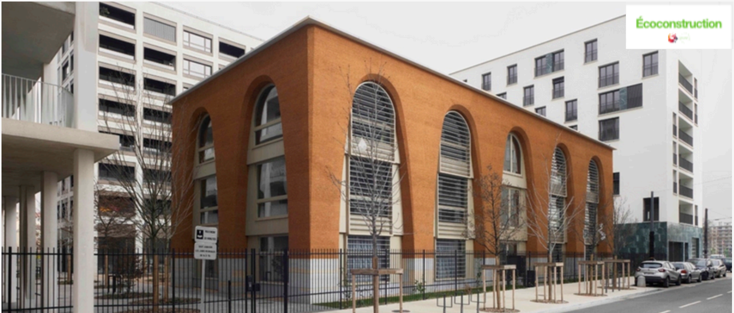
Construction en terre crue : immeuble de l'orangerie, Lyon – crédits : OGIC
