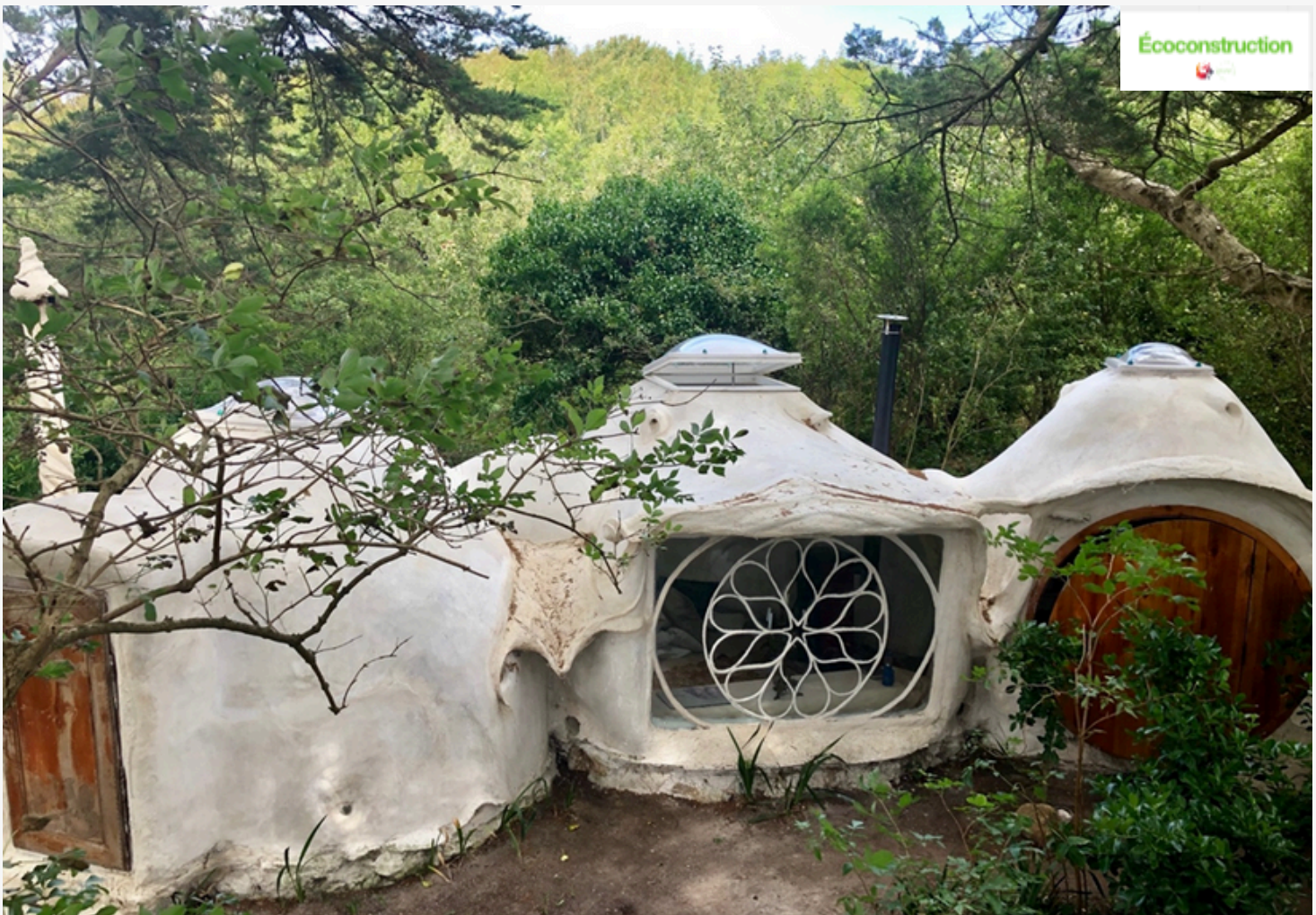
Kerterre : maisons dômes en chaux-chanvres conçues pour être réalisées par 5 femmes en 5 jours pour 5000 euros sans structure bois ni métal. Crédit : Kerterre
