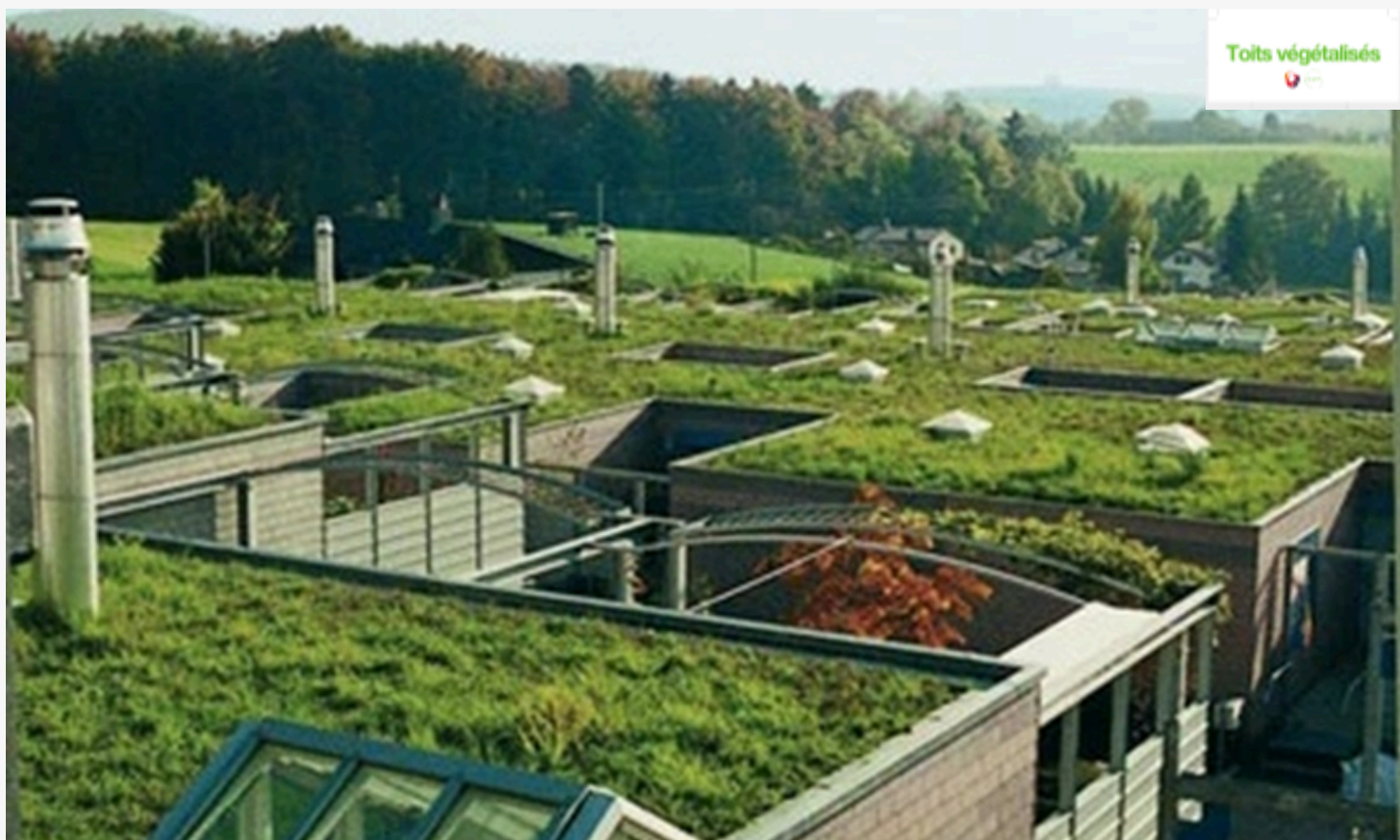
Infiltration des eaux de pluie, isolation acoustique et thermique : les toits végétalisés (ici : végétalisation extensive sur 5 à 7 cm de terre)
