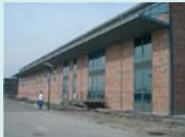
figure annexe 7 : vue du bâtiment
