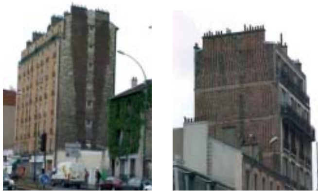
Figure 5.7 : conduits de fumée individuels
