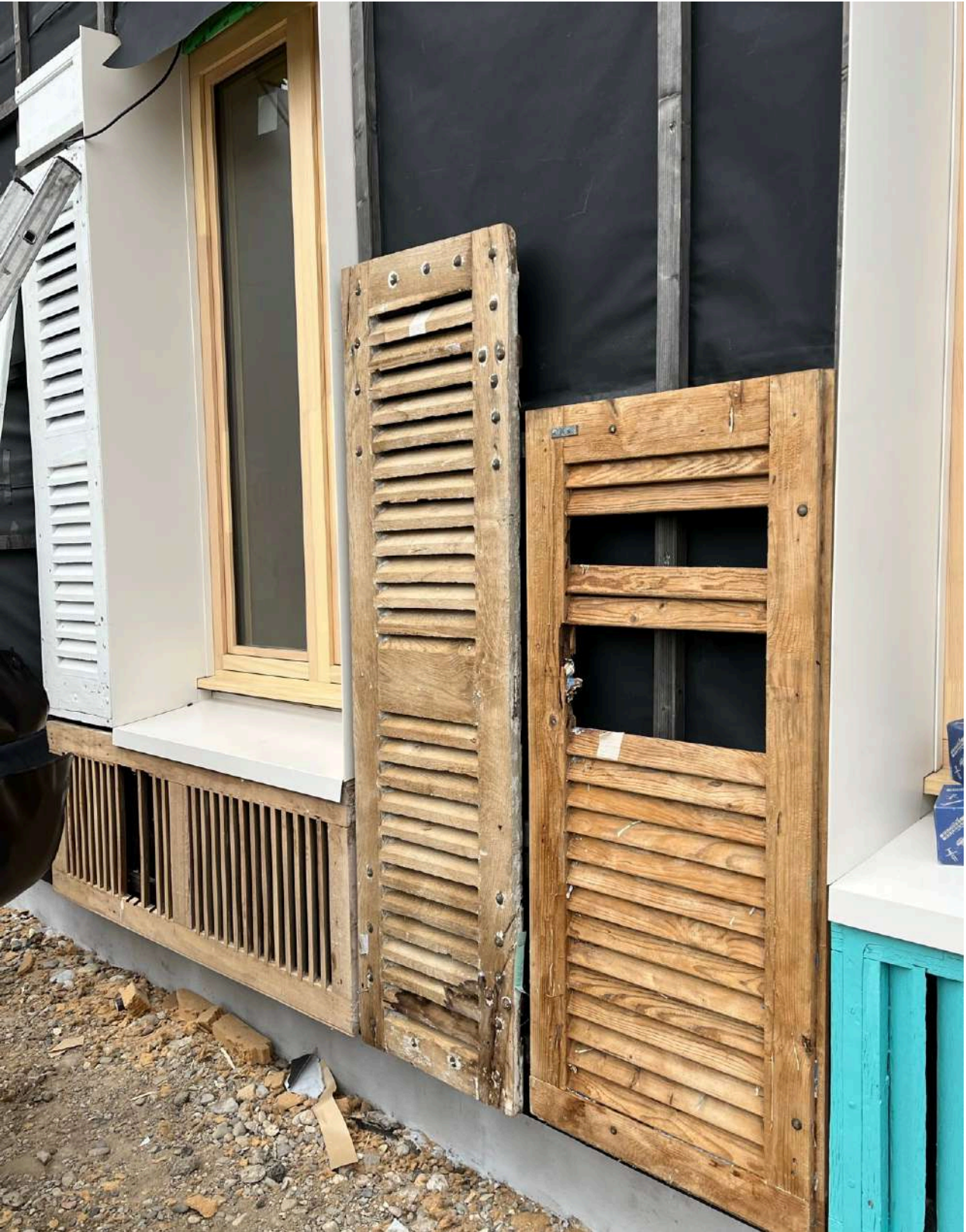
Photos de la pose du bardage issu de réemploi pendant la phase chantier.
