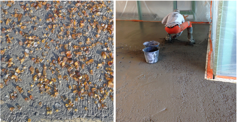
mise en oeuvre béton poli
