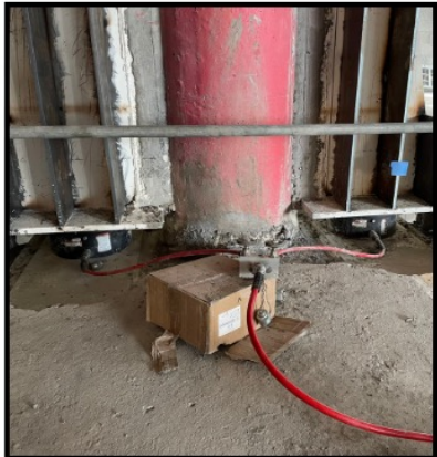
SUPPRESSION DES POTEAUX DU RDC
