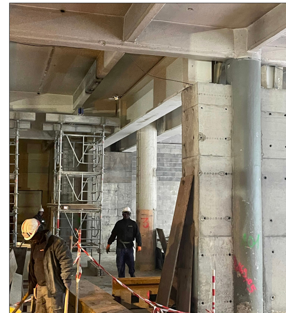
REPRISES EN SOUS-OEUVRE POTEAUX AMPHITHÉÂTRE
