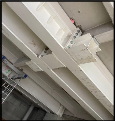
SUPPRESSION DES POTEAUX DU RDC
