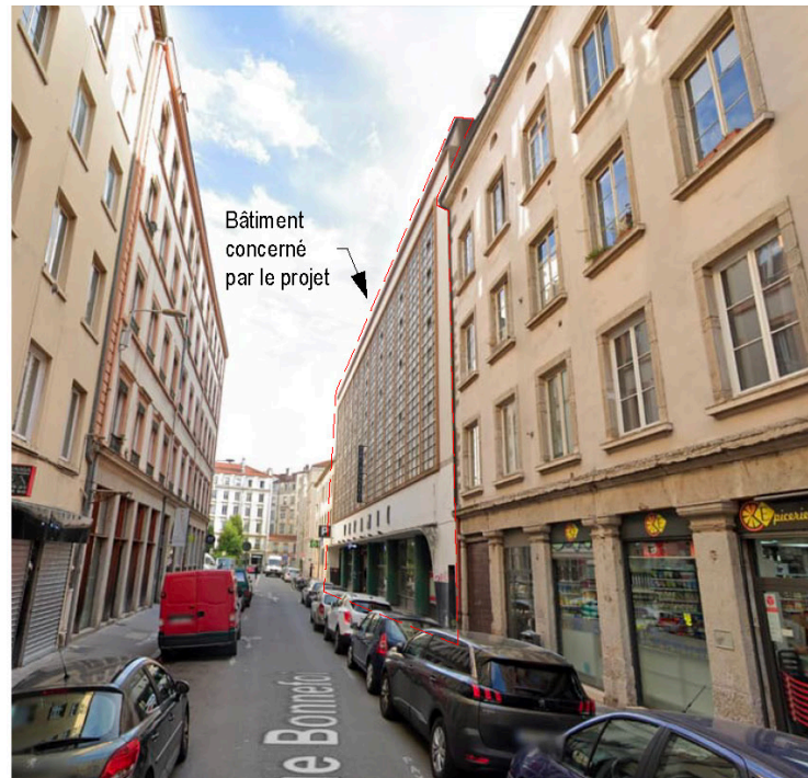
Vue depuis la Rue Bonnefoi côté Nord.
