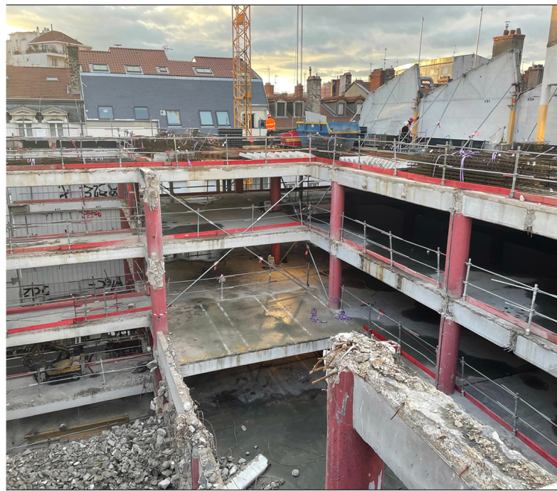
REPRISES EN SOUS-OEUVRE POTEAUX AMPHITHÉÂTRE
