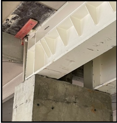
MISE EN PLACE DE CONSOLES PROVISOIRES POUR RSO DES POTEAUX ÉTAGES 1 À 6
