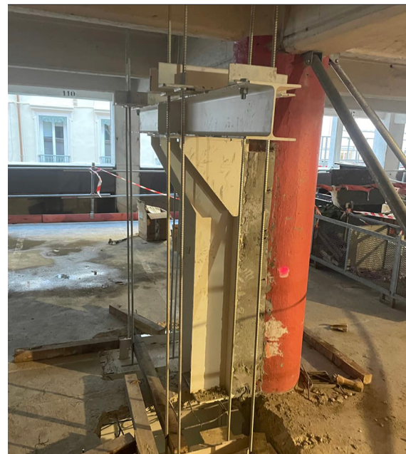
REPRISES EN SOUS-OEUVRE POTEAUX AMPHITHÉÂTRE
