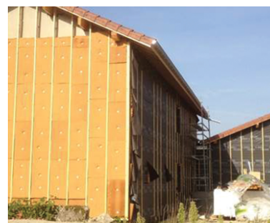
Mise en œuvre de l'isolation par l'extérieur avec finition bardage
