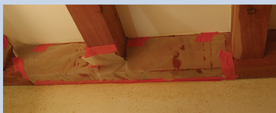
Charpente en mélèze gorgée de sève
