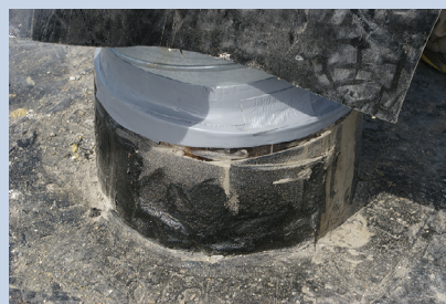
Utilisation de joint membrane souple
