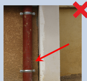
Collage du polystyrène « par plots » directement sur le mur existant. Ce type de pose crée une lame d'air entre le mur et l'isolant
