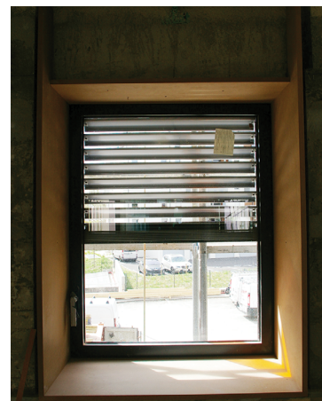
Ouverture orientée plein Ouest munie de brises soleil orientables. Les lames en aluminium permettent de conserver un apport lumineux par réflexion
