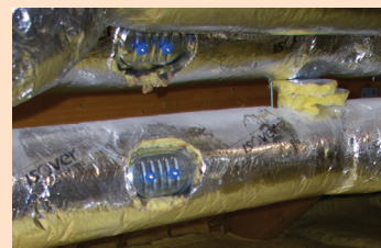
Le calorifuge n'a pas été remis en place
