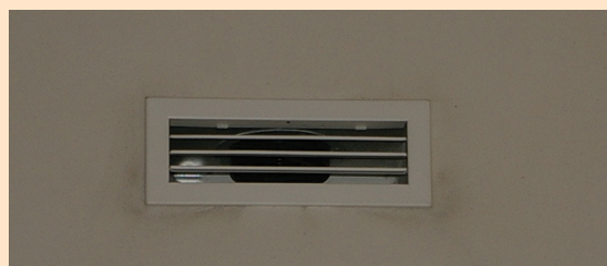
Apparition de taches sombres autour de la bouche de VMC
