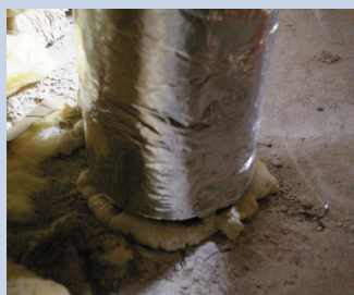
La mousse polyuréthane ne s'adapte pas aux variations dimensionnelles
