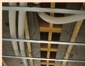
Utilisation de tubes semi-rigides
