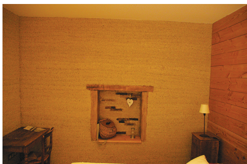
Vue de face d'un mur en béton banché. Les lignes horizontales sont dues aux lits successifs de chanvre
