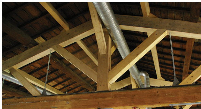
Les reprises de charpente à l'aide de bois lamellé-collé et d'éléments en acier ont permis de conserver les entrails d'origine en bois massif
