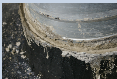
Le mortier liquide ne s'adapte pas aux variations dimensionnelles
